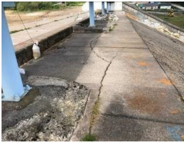
Longitudinal crack
