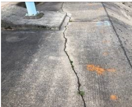
Longitudinal crack
