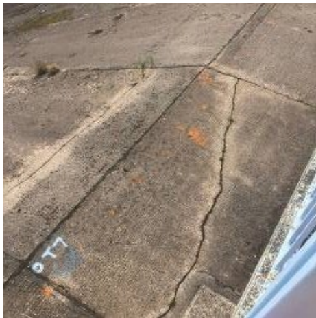
Longitudinal crack
